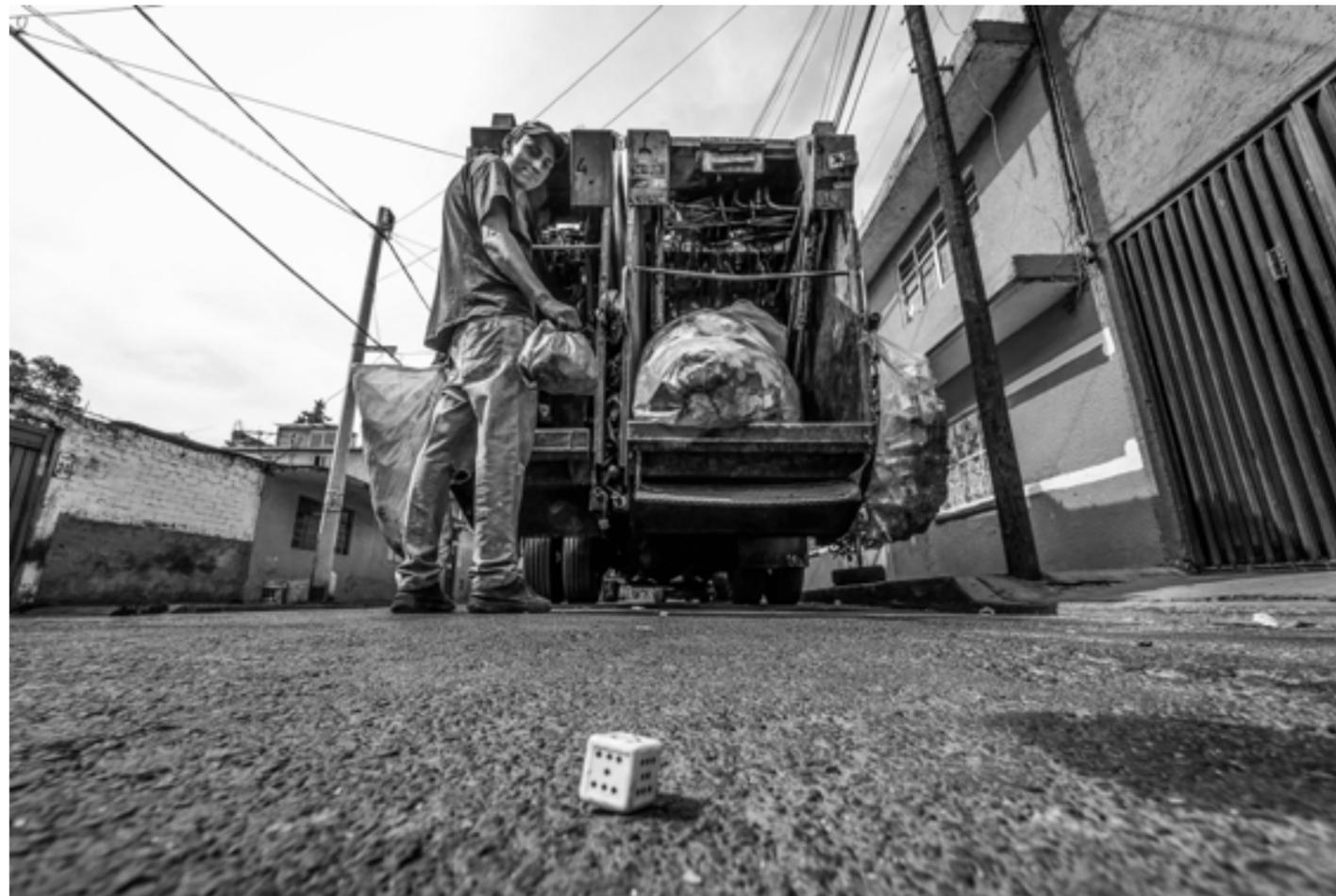
**Conforme se van recibiendo los residuos a lo largo del recorrido, se van separando los materiales reciclables y colgando en sacos en el camión.**
